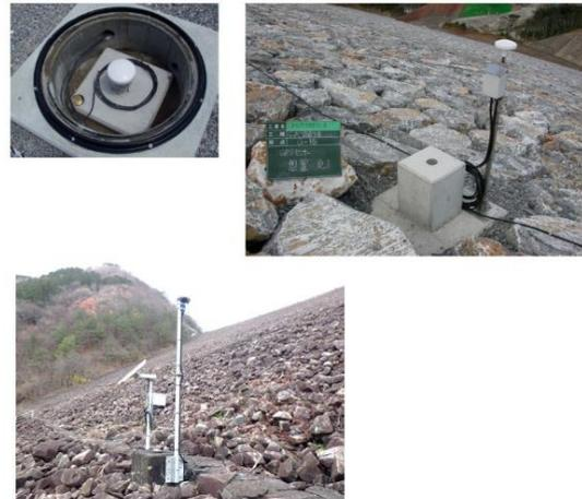
図 2.8-3. のり面での機器配置事例
