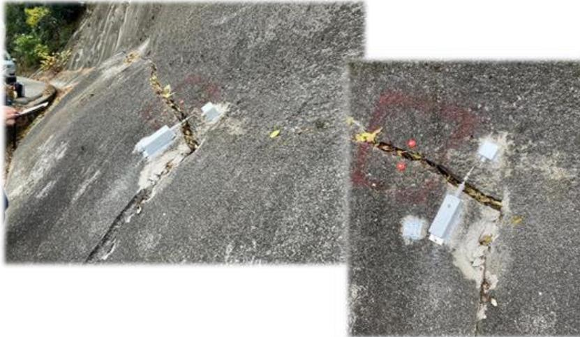
図 2.7-6. 法面モルタル吹付工のひび割れ監視の例
