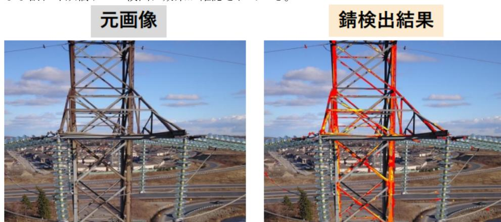
図3.5.4.2 送電鉄塔の点検でのサビ検出例
